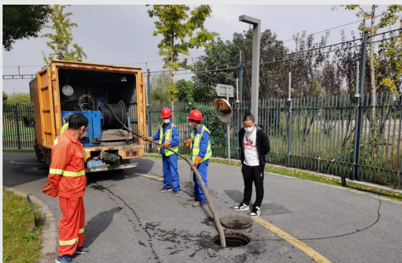
疏通污水管道
