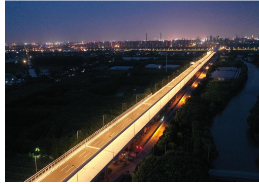
崧泽高架工程
