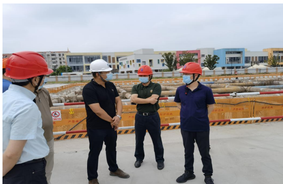
开展安全生产检查
